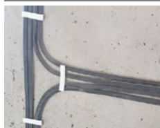
Příchytka pro plochý kabel
