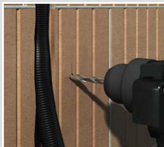
Vytvořte otvor o \varnothing 8 mm a hloubce min. 50 mm.
