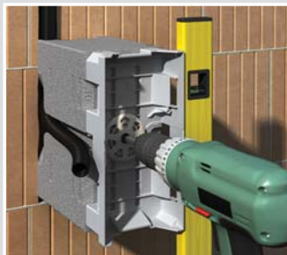
Přidržte držák přístrojů u zdi, vyrovnejte a upevněte pomocí hmoždinky.
