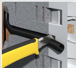
Trubku zatlačte do drážky na boku a zkraťte.
