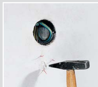
Přesnou polohu přístrojové krabice udávají po omítnutí jemné označovací štětiny signálního víka.
