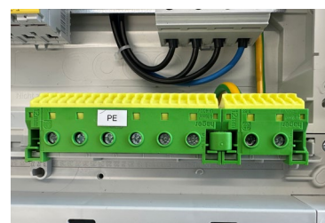
Připojení nulových a zemnicích vodičů
