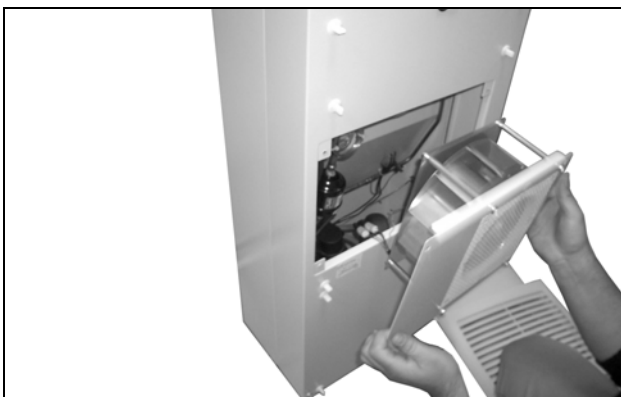
Obr. 64: Demontáž ventilátora vonkajšieho okruhu
