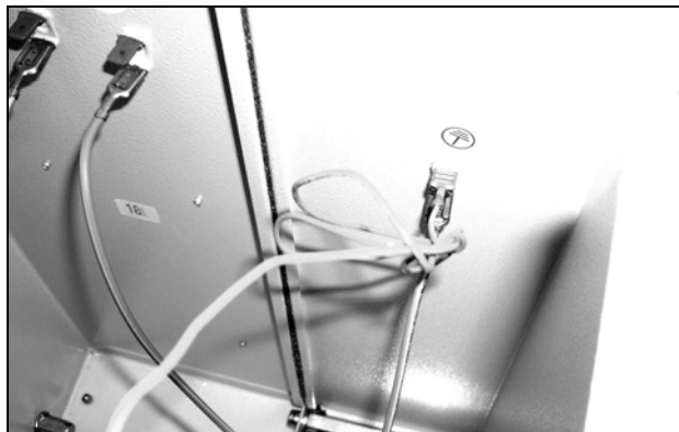
Obr. 68: Odpojenie zemniaceho kábla ventilátora (1)
