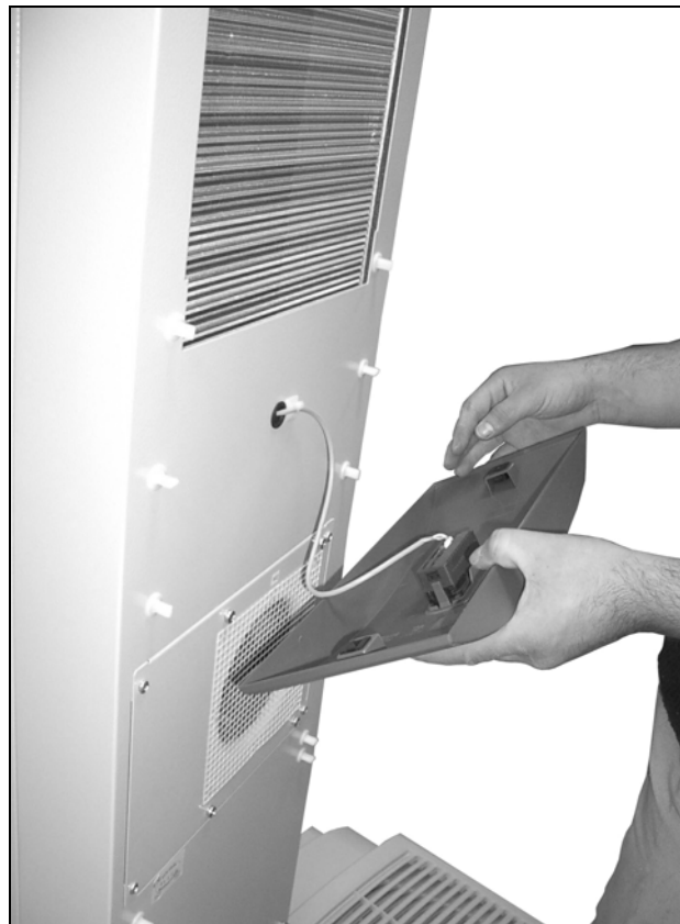
Obr. 59: Demontáž čelného modulu
